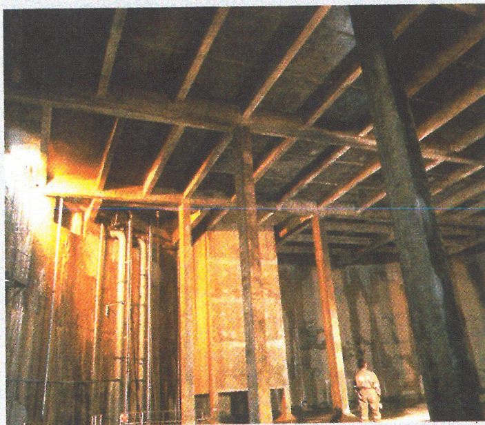
Bassin de retenue pluviale. La meilleure technique pour décanter les eaux par temps de pluies.
